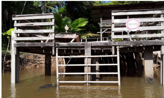
Ponton avec escalier métallique – La Comté
