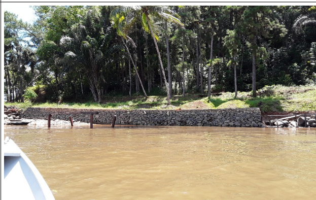
Enrochement berge – La comté
