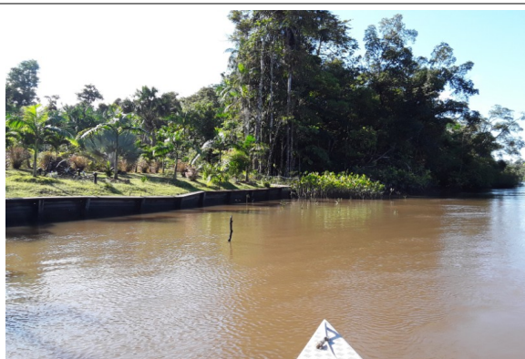
Mur de berge en bois – La Comté
