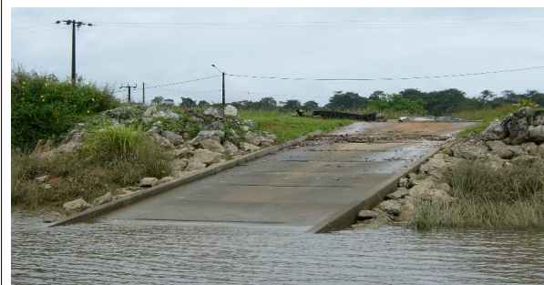
Cale béton -Commune de Régina
